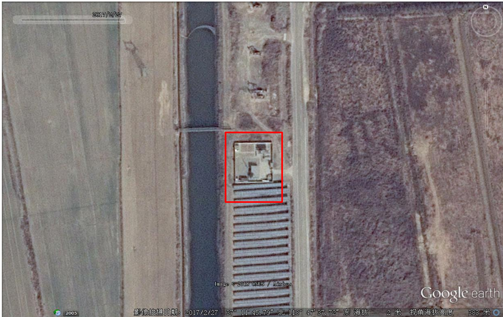
建成后工程现场卫星影像
