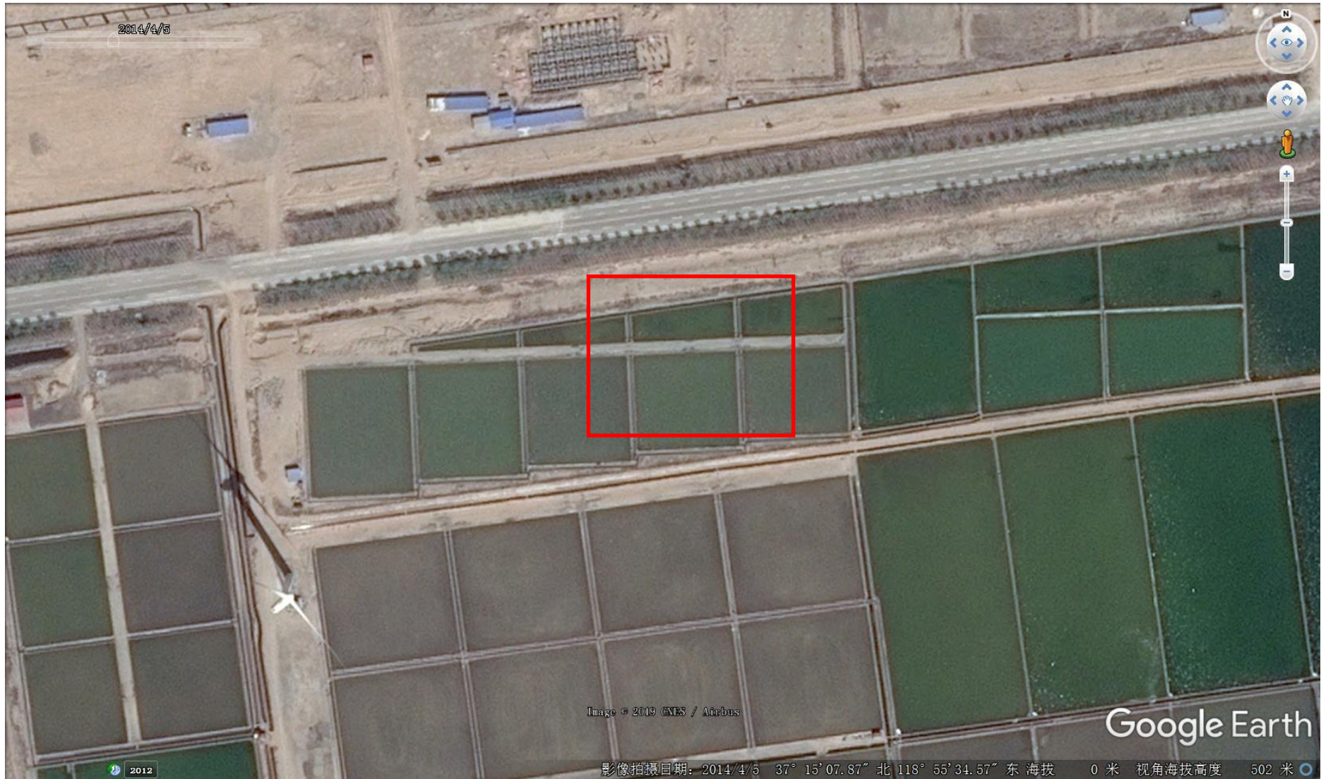
开工前工程现场卫星影像
